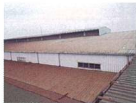
・金属折板屋根
