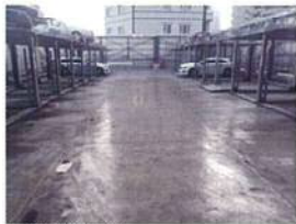
・屋上(駐車場)
