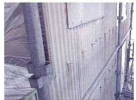
・外壁(スレート)
